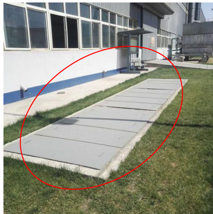
生活污水户外沉淀池
